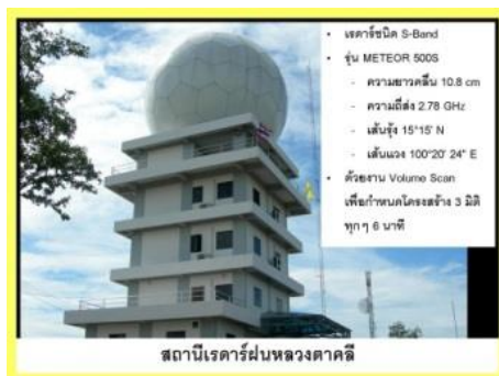
ภาพที่ 3 เรดาร์ตรวจวัดกลุ่มเมฆและฝน สถานีเรดาร์ฝนหลวงตาคลี (หนึ่งหทัย ดันดีพลับทอง, 2553)
