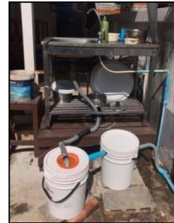
ข. ถังดักไขมันที่นำไปติดตั้งใต้ซิงค์ล้างจานในครัวเรือน
