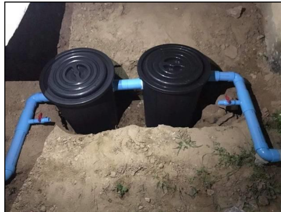
ข. ถังดักไขมันที่นำไปติดตั้งในร้านจำหน่ายอาหาร
